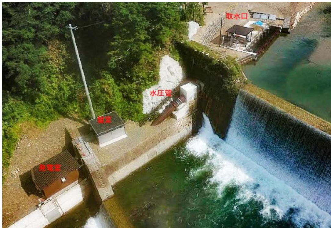
写真-3 堤体穴あけ方式による開口部の例
