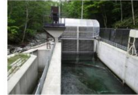
図7.8 沈砂池・除塵機・排砂口
