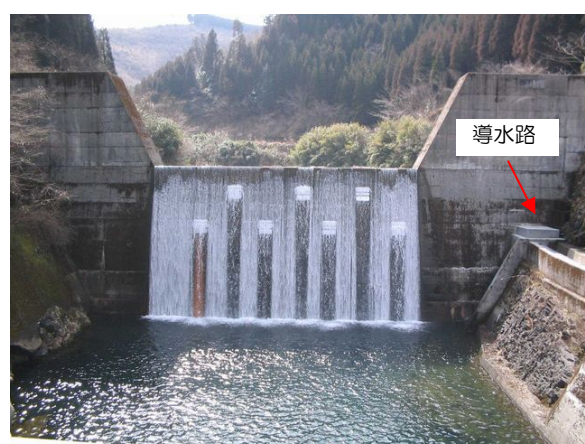
砂防堰堤（下流側）
