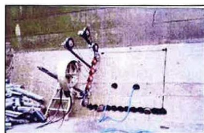
写真 付.1 取水口の掘削イメージ
