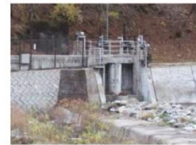
図7.9 取水口のゲート
