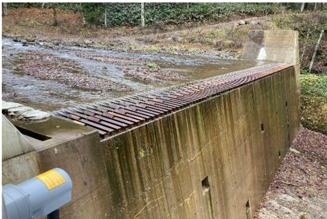
写真-4 チロル方式による取水設備設置例
