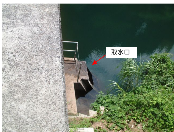
砂防堰堤（上流側）
