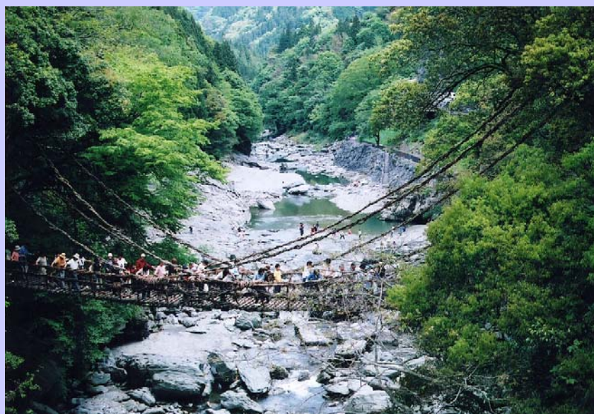
善徳護岸（四国山地砂防事務所）
