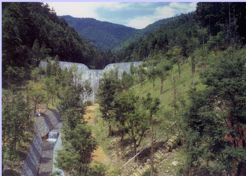
西の谷川えん堤（京都府）
