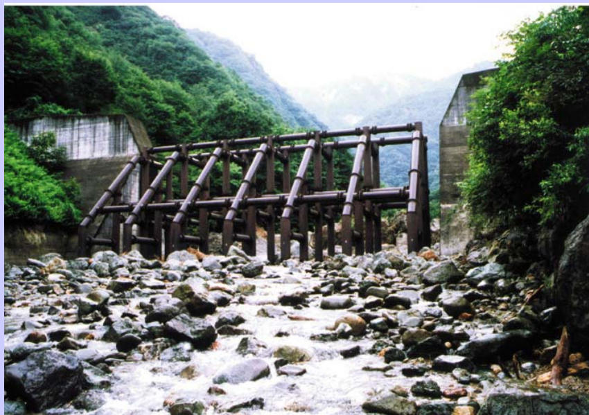
五十沢砂防えん堤 (湯沢砂防事務所)
