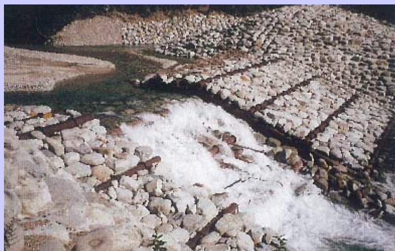
左俣谷床固工（神通水系砂防事務所）
