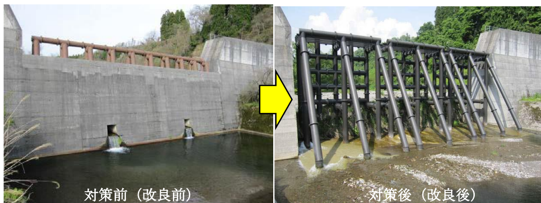
事例 3：鋼製スリット化した事例（日野川流砂系）
