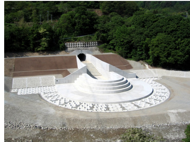
④土砂バイパス吐口
