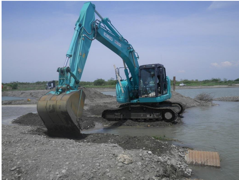
河道掘削及び仮置き(中部地方整備局)
