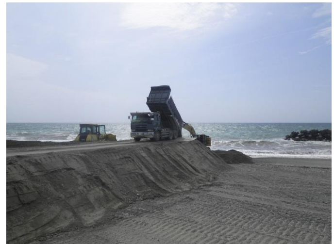
運搬及び養浜の実施(静岡県)
