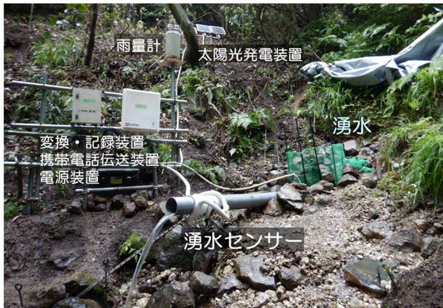
図8 始良カルデラ壁(垂水市仏石川)に設置した湧水センサー
