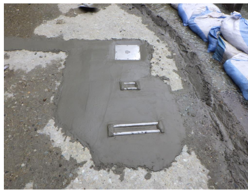
図-2 足洗谷観測水路の水路床に（上）TDR センサーを設置中、（下）設置後の様子
