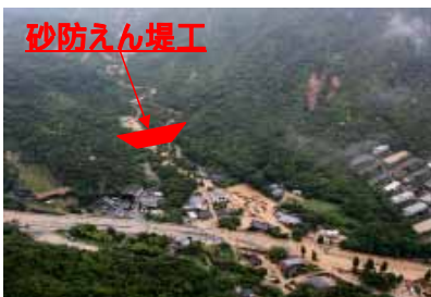
砂防えん堤工 1基(高さ9m)
