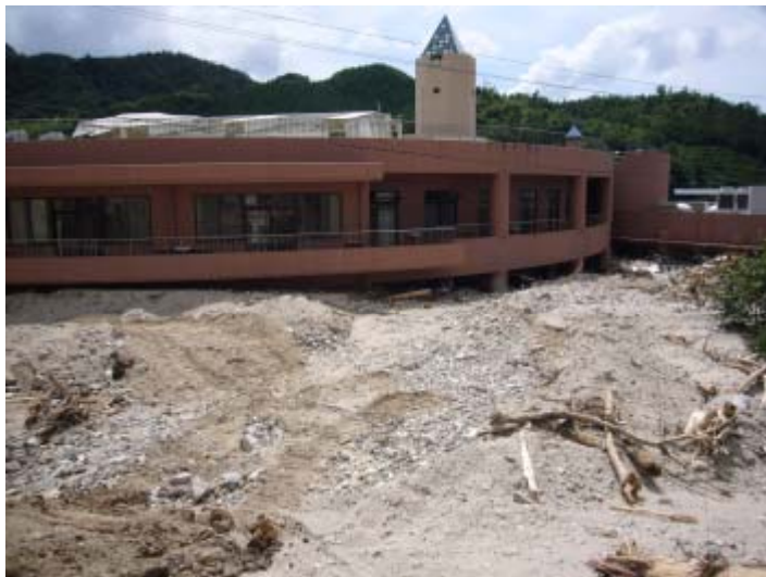
土石流により流出・堆積した土砂
