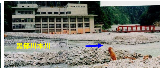
土砂で埋没した黒部第二発電所
