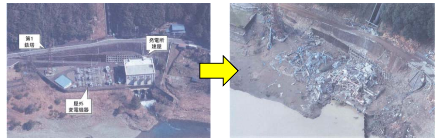
台風12号による関西電力長殿発電所への被害(発電、配電機能の喪失)
