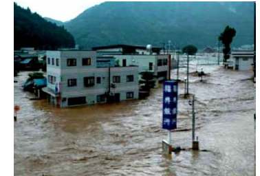
土砂・洪水氾濫による床上・床下浸水被害 → 資産への被害
