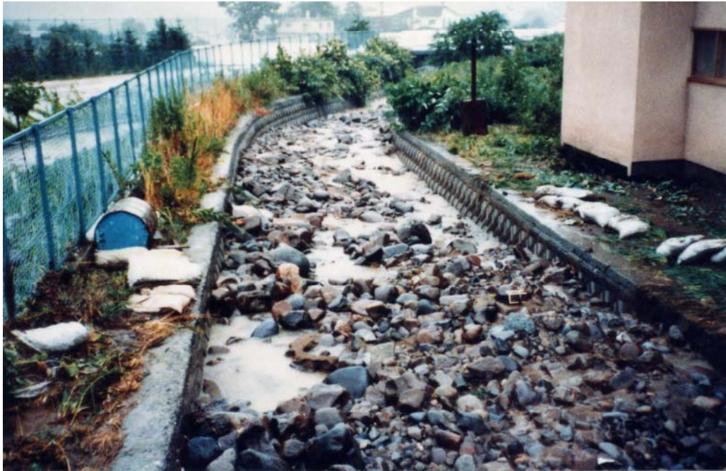
河道に堆積した大量の土砂
