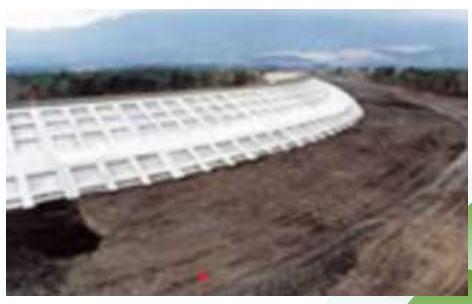
導流堤 土石流の氾濫を防ぎ、 遊砂地まで安全に導流
