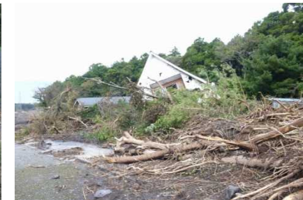
家屋被災状況
