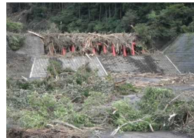
砂防施設で捕捉した流木
