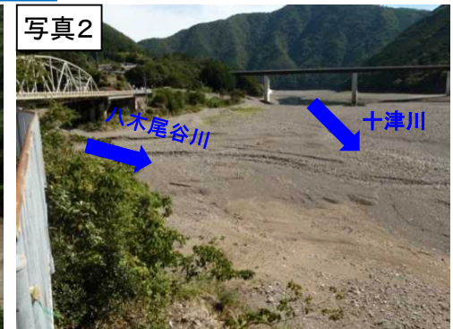
上流からの土砂流出による河床上昇状況
