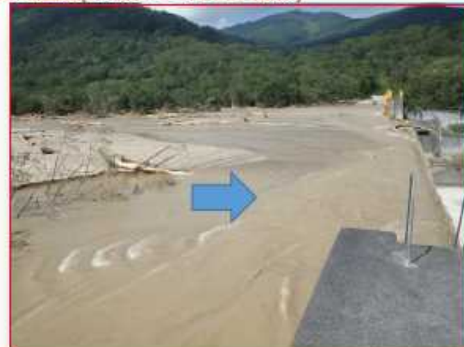
災害発生後(平成28年9月2日 撮影)
