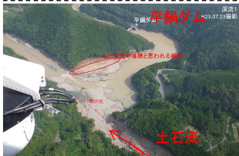
貯水池へ流入した土石流
