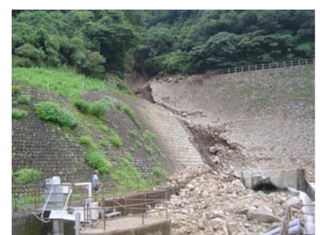
太田川発電所への被害(地理院地図より) 水槽に流入した土砂(二岡ら(2006))
