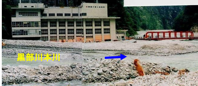
土砂で埋没した黒部第二発電所
