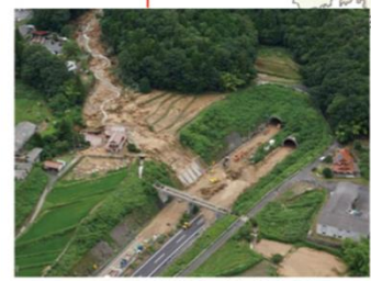
山陽自動車道 (東広島市) 7/14通行止め解除
