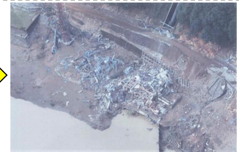
台風12号による関西電力長殿発電所への被害(発電、配電機能の喪失)
