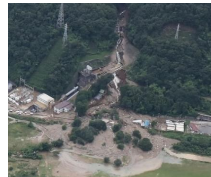
太田川発電所への被害(地理院地図より) 水槽に流入した土砂(二岡ら(2006))
