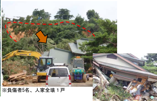
岩手県盛岡市 がけ崩れによる被害の状況
