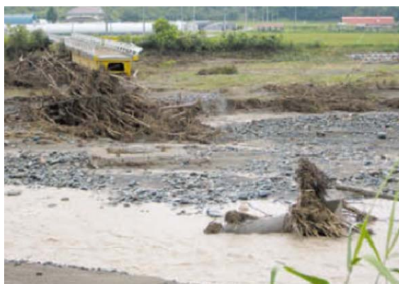
流木により流失した橋梁
