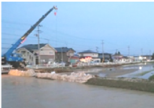
岩手県矢巾町 北上川水系岩崎川 堤防決壊(応急復旧の様子)
