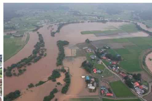
岩手県紫波町 北上川水系北上川 氾濫状況
