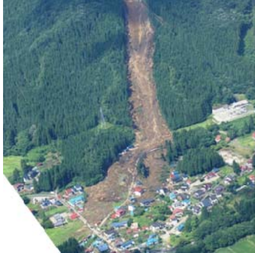
秋田県仙北市 土石流による被害の状況
