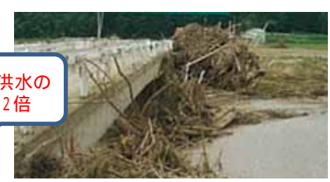
ダムがなかった場合 橋に引っかかった流木(事例)
