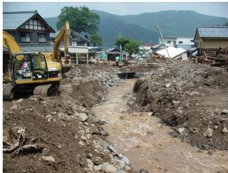
一乗谷川を閉塞した土砂の撤去状況 (22日撮影)
