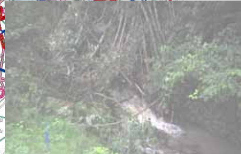
常楽寺川(出雲崎町) 土砂崩落
