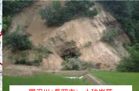
国沢川(長岡市) 土砂崩落
