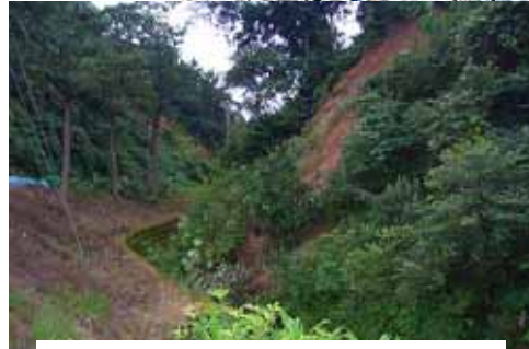
高鳥川(長岡市) 土砂崩落
