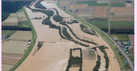
越水による堤防の法崩れ(常呂川)
