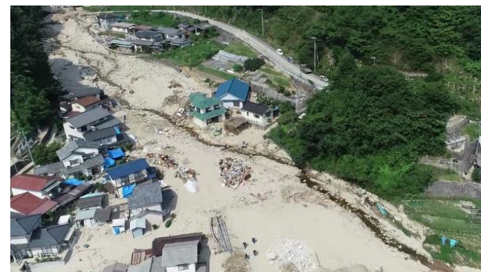
土砂・洪水氾濫(今次洪水)
