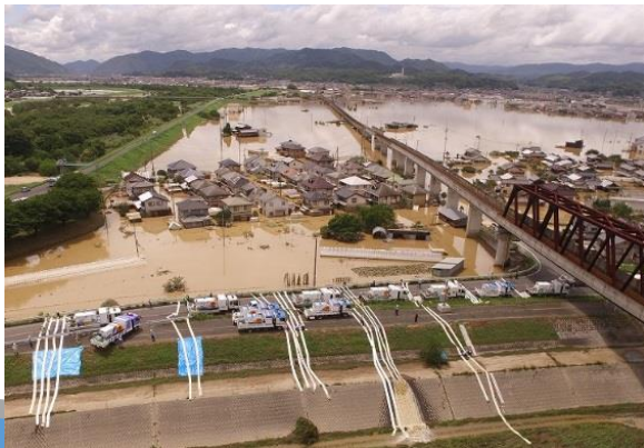
排水ポンプ車による緊急排水
