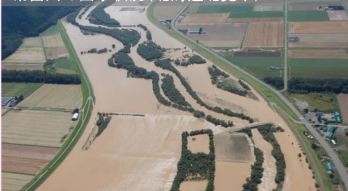
越水による堤防の法崩れ(常呂川)
