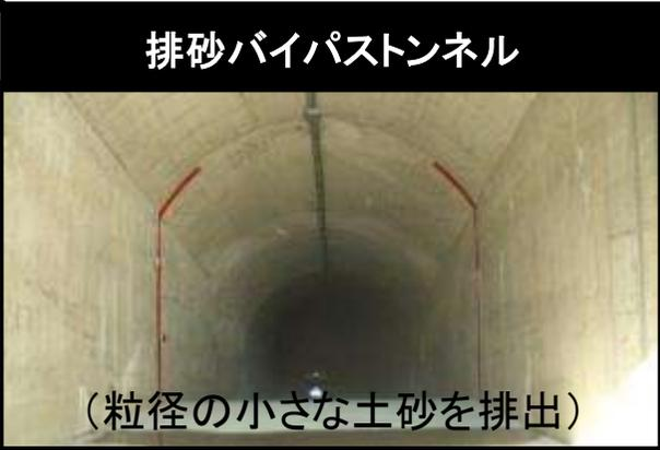
○洪水を利用して、排砂ゲートから土砂を排出
