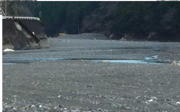
貯水池上流端の堆砂状況(長安口ダム)
