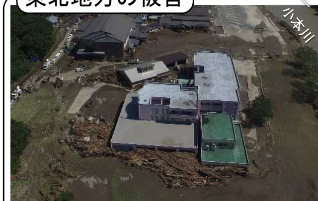
浸水被害状況(岩手県小本川)
