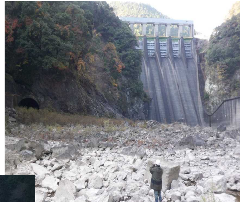
ダム下流の河道(長安口ダム) ダムから土砂が供給されなくなり、細粒分が流出し粗粒化
