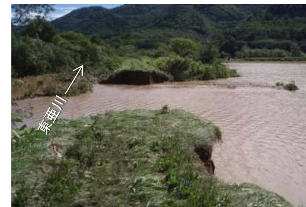
堤防の決壊(常呂川水系東亜川)
