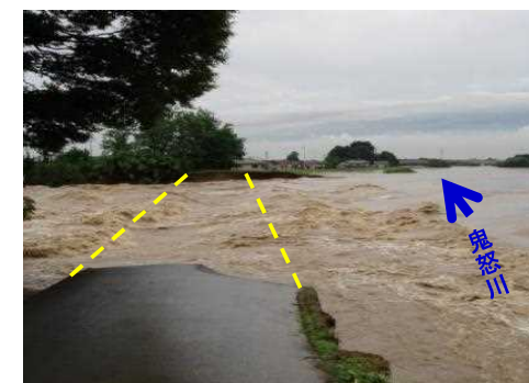
被災状況(拡大写真)
