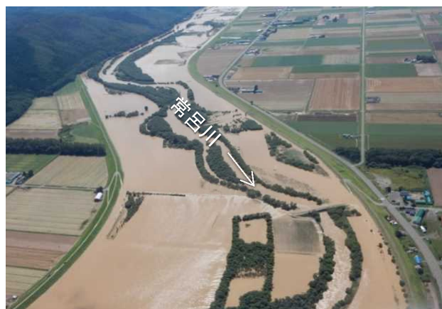
出水状況(常呂川)
