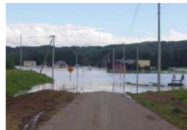
溢水による浸水被害(石狩川)
