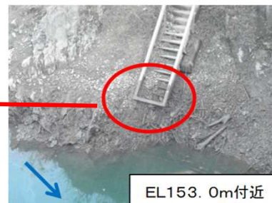
管理用船舶の係留施設
