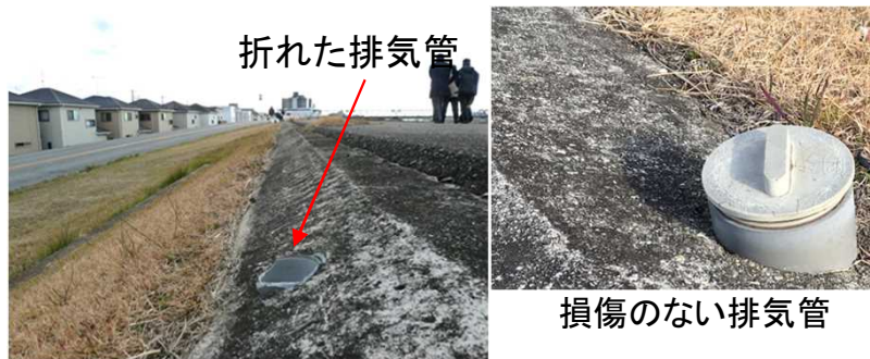
川裏法肩に設置された排気管の破損状況(加古川)
