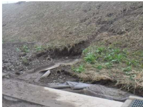
法尻の侵食に伴い露出した吸出し防止シートに見られる繋ぎ目の開き(那珂川)
