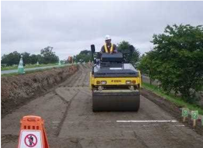
振動ローラによる締固め
