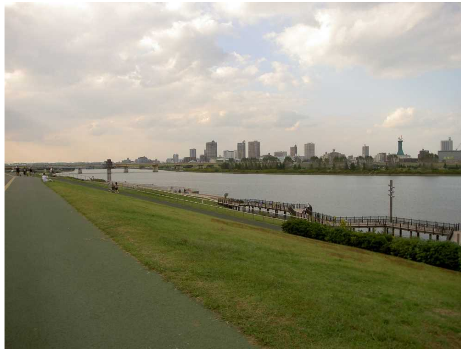
緩勾配化や芝張りによって環境や景観に配慮した事例
