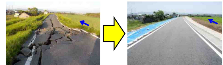
熊本地震 緑川左岸8.4kの復旧
