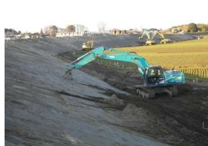
土羽バケットによる法面整形
