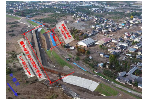
千曲川左岸57.5k地点の洪水による堤防被災箇所の復旧
