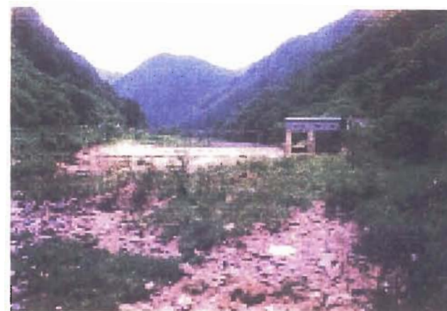
発電取水施設下流の「減水区間」
