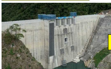
10月11日 状況写真
