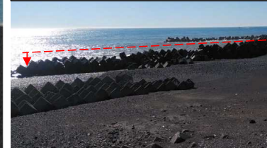
駿河海岸【直轄】(消波ブロック沈下)
