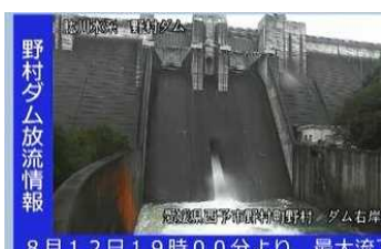
野村ダム メディアを通じて住民への提供情報 令和元年8月台風第10号時の画像配信状況 ※西予CATV契約者のみ視聴可能
