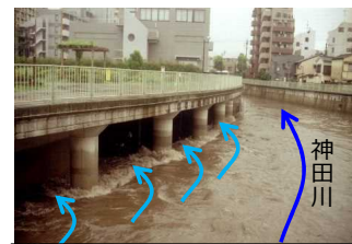
神田川・環状七号線地下調節池の流入状況(神田川取水施設) ※写真は過去の洪水時
