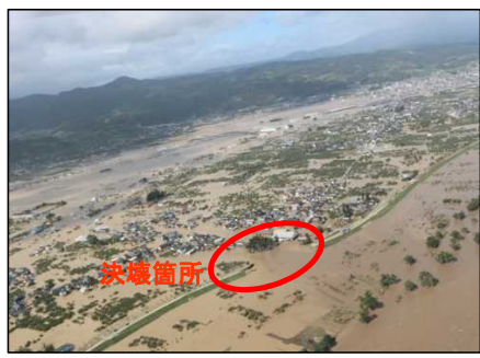
浸水状況(10月13日12時) 76
