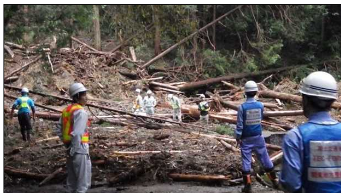
協力企業と連携した被災状況調査(栃木県栃木市)
