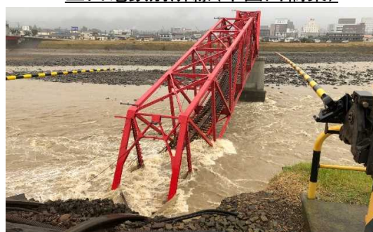
上田電鉄別所線(千曲川橋梁)
