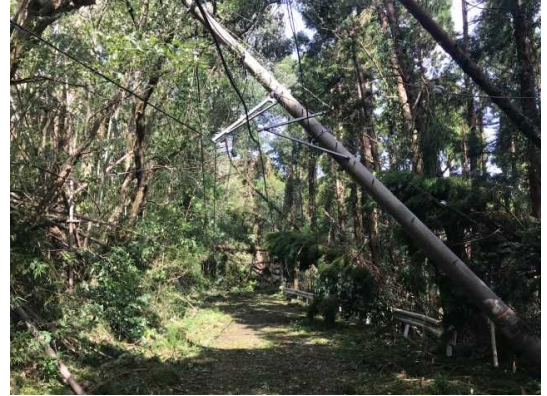
倒木・電柱・電線が絡んだ車道の閉塞(県道21号 市原市)
