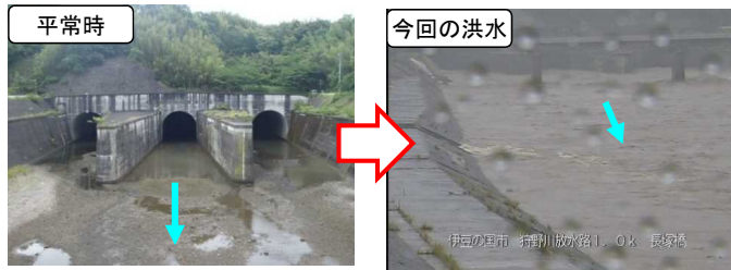
狩野川放水路により、約1,000m 3 /sの洪水を分派し本川の流量を低減
