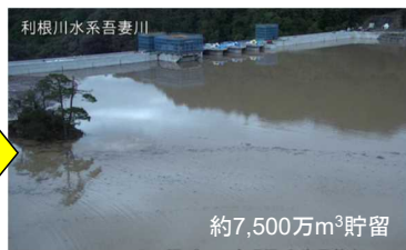
10月15日 17:00 状況写真
