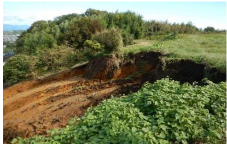
斜面の頭部の状況
