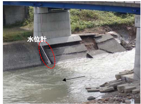
碓氷川 安中水位観測所
