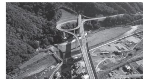
▲静岡方面を望む下部温泉早川インターチェンジ(IC)
