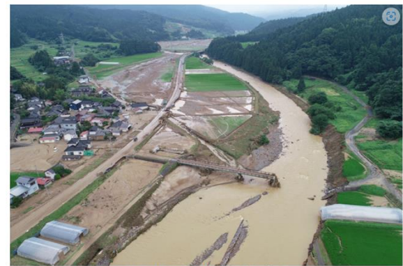
荒瀬川の氾濫により前山橋へ続く道路が消失
