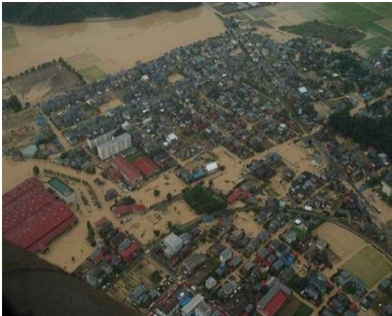
氾濫水により水浸しになった市街地
