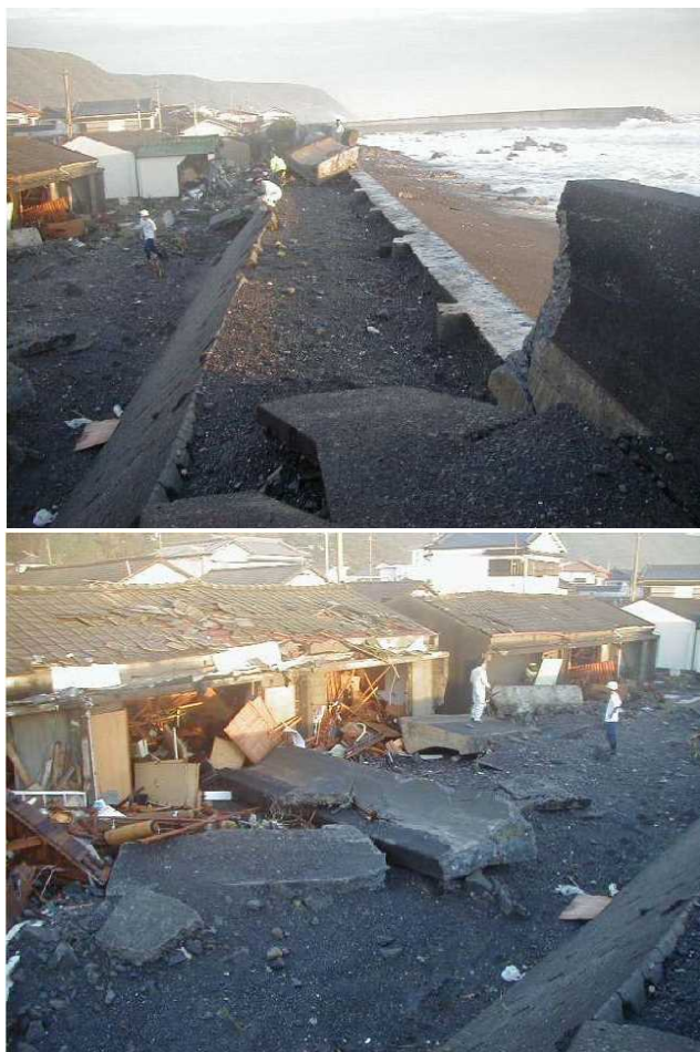
平成16年台風第23号による菜生海岸の被災状況
