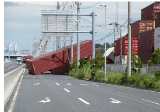
空コンテナの崩れによる道路閉塞 (東京港中央防波堤外側バンプール)
