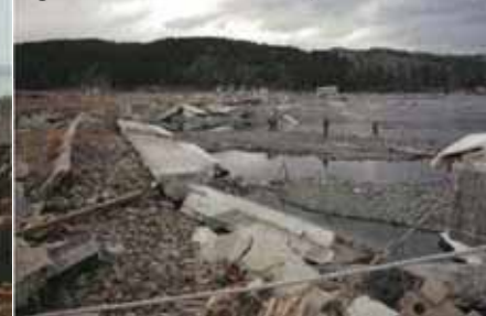
⑤七ヶ浜海岸 菖蒲田地区 (堤防天端裏法被災) ⑥岩沼海岸 相ノ釜・納屋地区 (堤防決壊)
