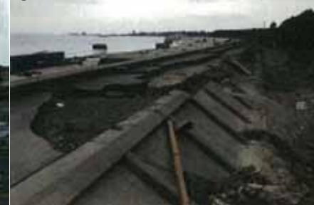
⑤七ヶ浜海岸 菖蒲田地区 (堤防天端裏法被災) ⑥岩沼海岸 相ノ釜・納屋地区 (堤防決壊)
