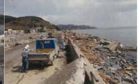
⑤七ヶ浜海岸 菖蒲田地区 (堤防天端裏法被災) ⑥岩沼海岸 相ノ釜・納屋地区 (堤防決壊)
