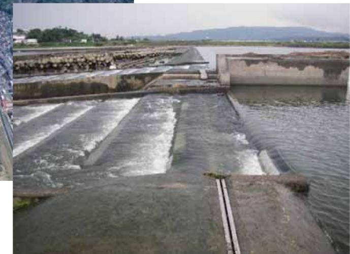
図4-6 堰において貯留制限を行うことにより、維持流量 (魚類の移動に必要な流量)を確保 (高梁川)
