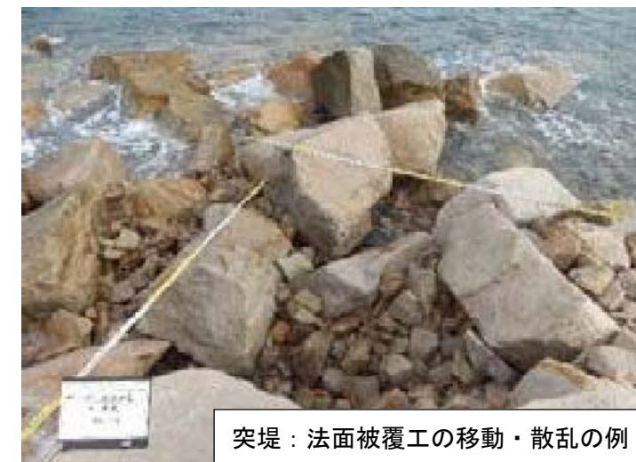
図-3.2 巡視 (パトロール) において確認する特徴的な変状の事例
