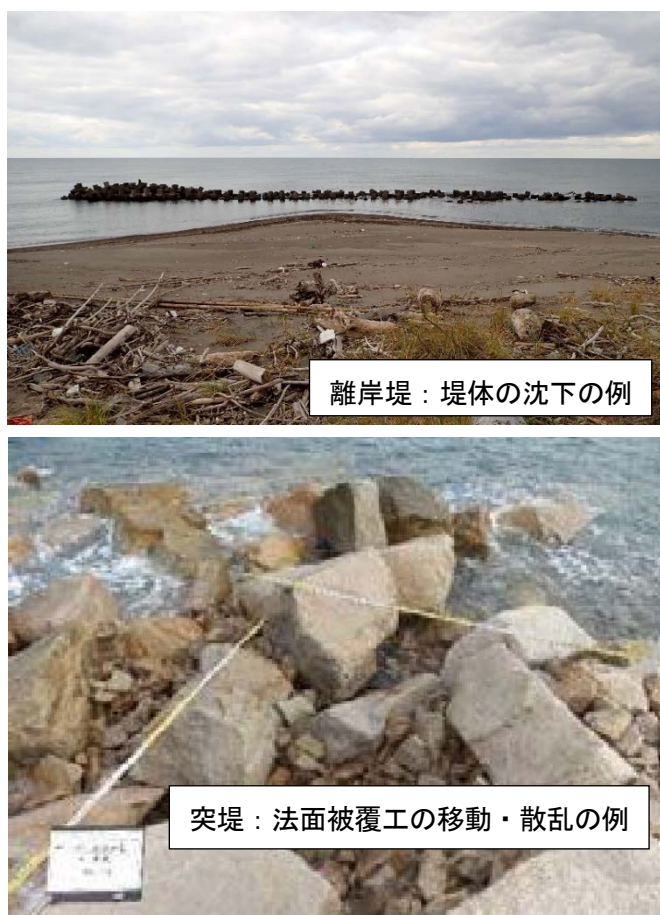
図-3.2 巡視（パトロール）において確認する特徴的な変状の事例
