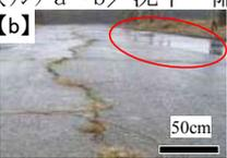
※沈下は、隣接施設との天端高の比較、降雨後の水たまり等により、発見できる。 | 空洞部に、堤体土・モルタルを充填後、コンクリート・アスファルト等による張り替え等を行う。                                                        |
