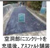
空洞部にコンクリートを充填後、アスファルト舗装 |
