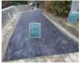
空洞部にコンクリートを充填後、アスファルト舗装
