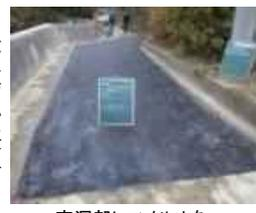
空洞部にコンクリートを充填後、アスファルト舗装 |
