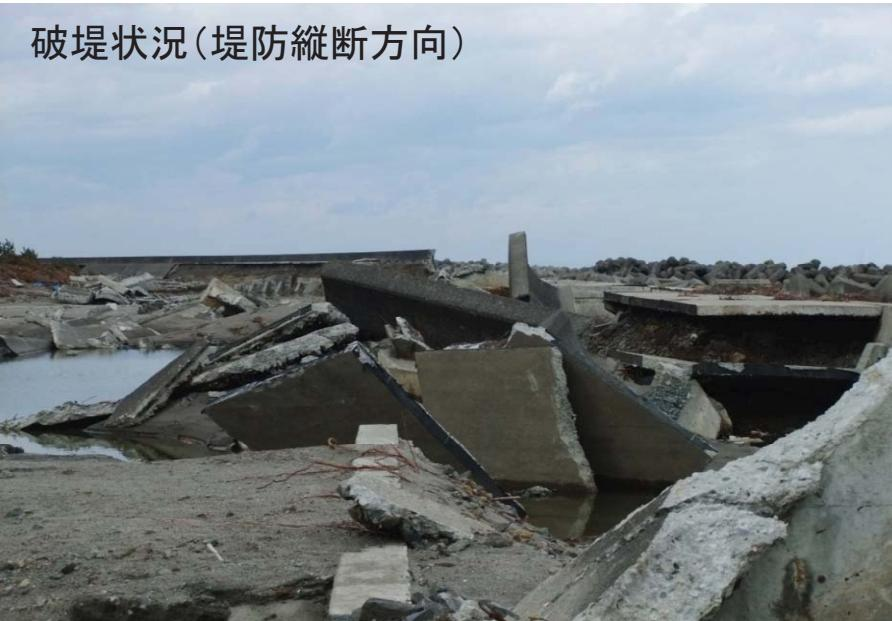
離岸堤被災状況(消波ブロック沈下及び飛散)
