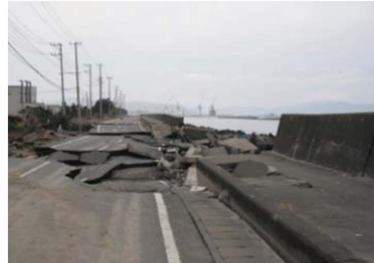
雲雀野地区 離岸堤 沈下・ブロック飛散
