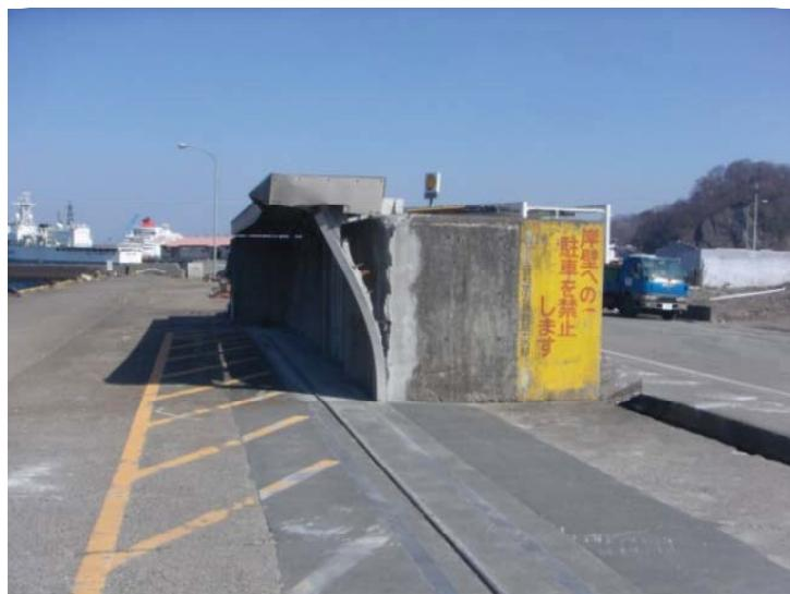
湾口防波堤 ケーソンの崩壊及び滑動
