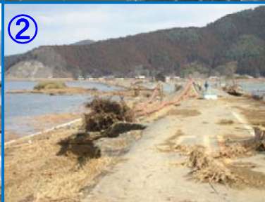
② 釜谷地区破堤状況。（R4.5k付近）
