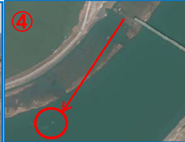
④ 北上大橋左岸側のトラスが落橋し、上流へ約400m流される。（L4k付近）
