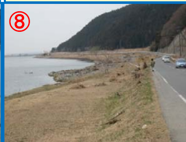
⑧ 流木が堤防天端にまで漂着。（L11k付近）
