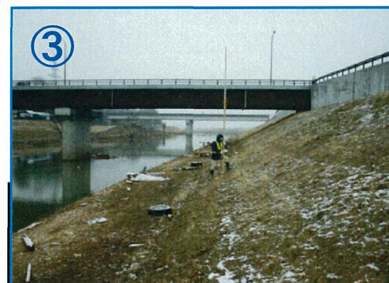
漂流物の状況。 (R5.0k付近)
