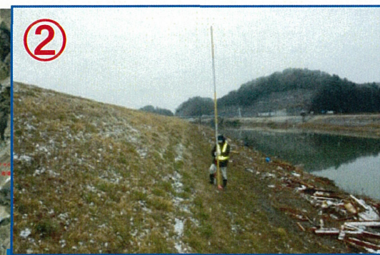
漂流物の状況。 (L4.6k付近)
