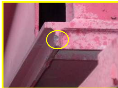
<ステップ（丸鋼）打痕跡>
