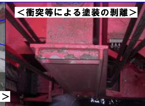
< 6 号 ゲート 左岸 堰柱 への 摩擦 痕 >
