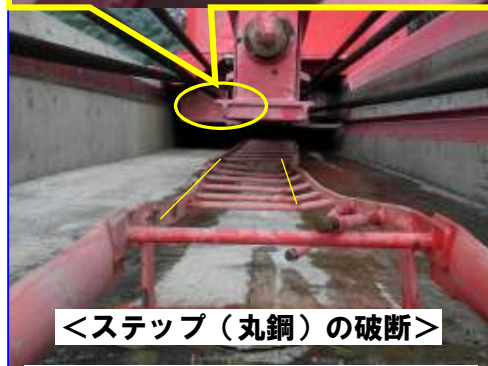
< 2 号 右岸 階段 損傷 >
