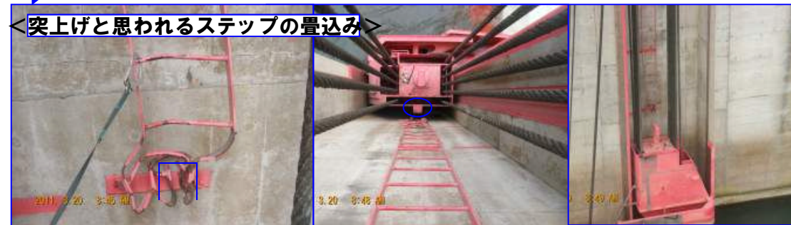
< 5 号 ゲート 右岸 階段 の 損 傷 >
