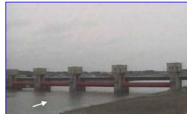
応急復旧後の状況
