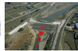
天神床止（16.2k付近）昭和30年代頃建設
