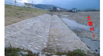
平成16年10月洪水被災箇所の復旧状況
