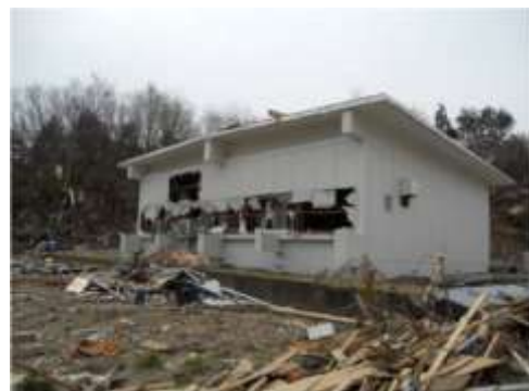
津波により被災した通信設備
