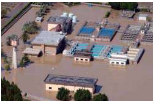
平成 17 台風 14 号により 冠水した富吉浄水場 24) (宮崎県宮崎市)
