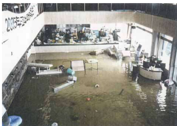
平成 12 年台風 14 号により浸水した 西枇杷島町役場ロビー 15)
