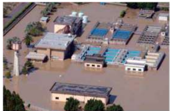
冠水して一面泥水に浸った富吉浄水場 115)
