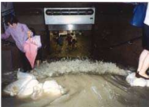
平成 11 年福岡市地下鉄入口の浸水状況 36)
