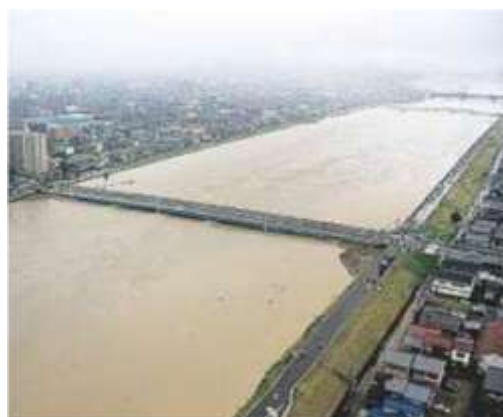
平成 12 年東海豪雨 国道 1 号一色大橋付近の状況 19)
