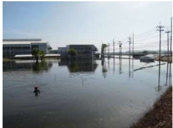
2011 年タイ洪水における工業団地の浸水状況 123)
