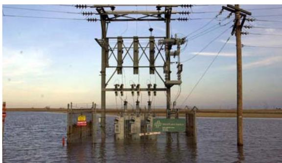
2005年ハリケーン・カトリーナ水害による電力施設の損傷<sup>28)</sup>
