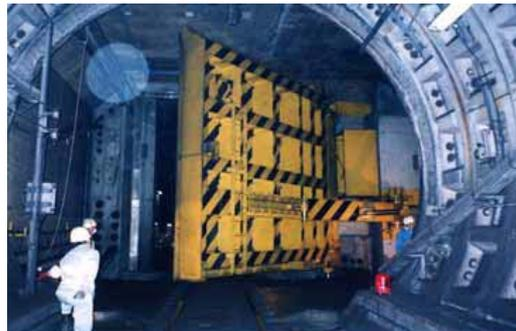
トンネル内浸水対策<sup>105)</sup> (防水ゲート)
