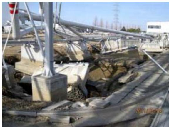
製造設備被害状況（配管・架構）<sup>125)</sup>
