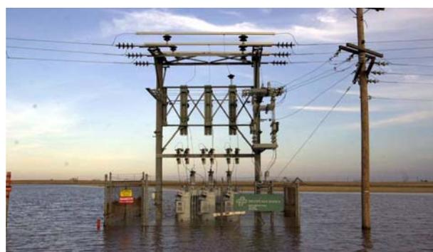
浸水による電力施設の損傷
