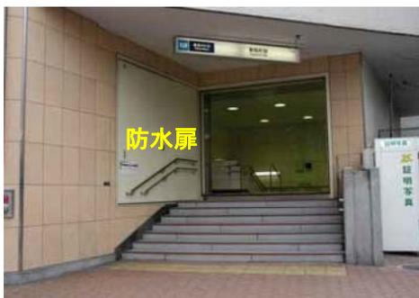
地下鉄の出入口における浸水対策<sup>105)</sup> (防水扉)
