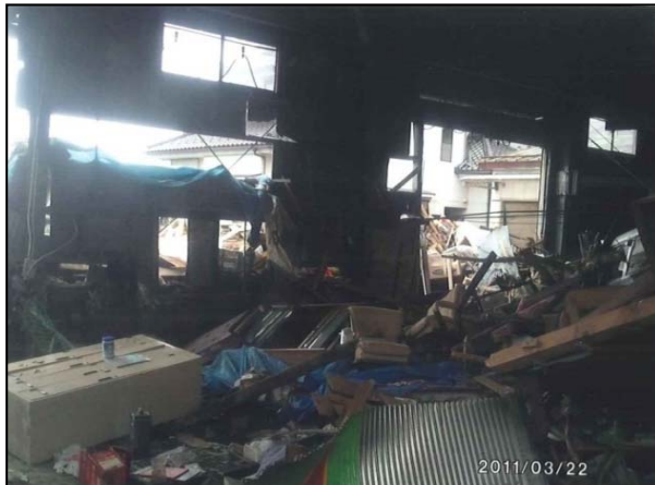
工場内の生産用設備・機器等が全損
