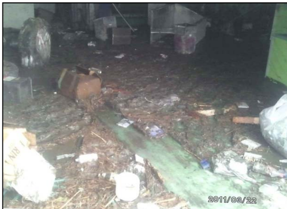
泥が堆積した工場内
