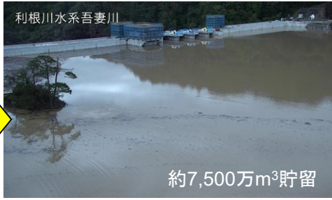
10月15日 17:00 状況写真
