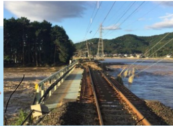
両毛線 太平下～栃木間 永野川橋梁 橋台背面流出
