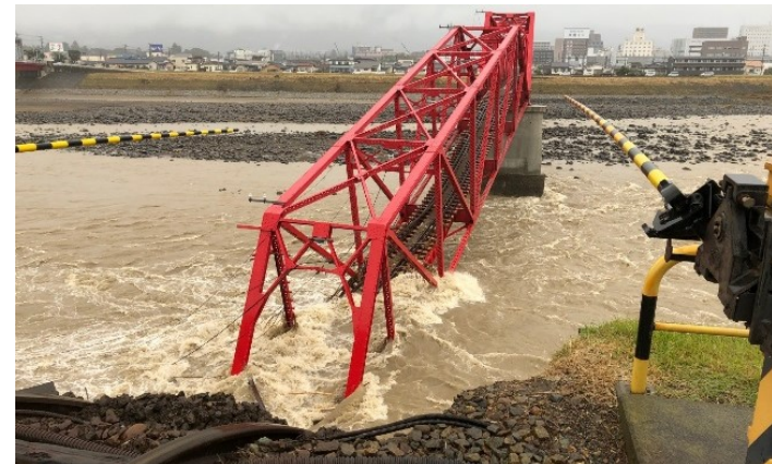
上田電鉄別所線(千曲川橋梁)
