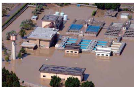
平成17台風14号により冠水した富吉浄水場 27) (宮崎県宮崎市)
