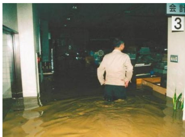
平成16年台風23号により浸水した 大江町役場 19)
