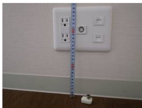
床から 20cm に差込口がある コンセントとモジュージャック
