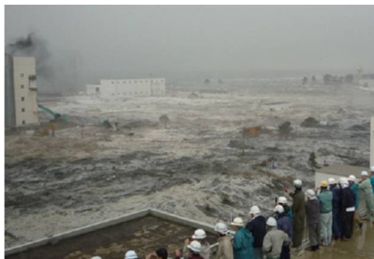
津波により浸水する南蒲生浄化センター
