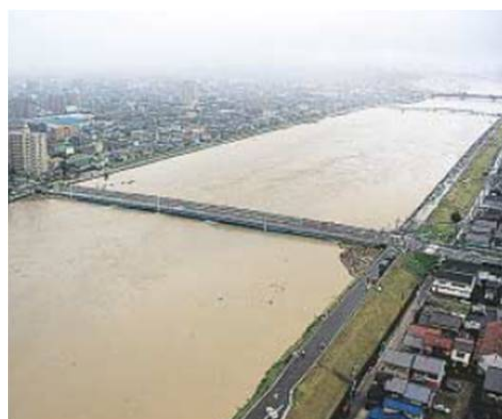
平成 12 年東海豪雨 国道 1 号一色大橋付近の状況 22)
