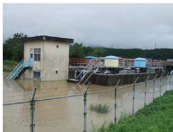
冠水して一面泥水に浸った鴨庄浄水場 126)
