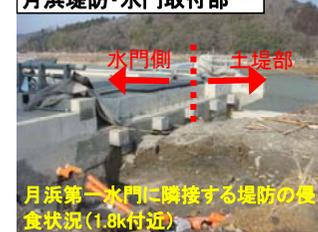
月浜第一水門に隣接する堤防の侵食状況(1.8k付近)
