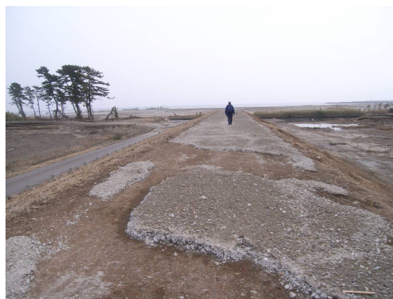
◆天端舗装の剥離・流送：その下の堤体土の侵食は軽微
