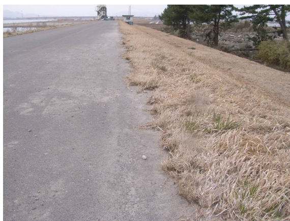
◆堤内側のり肩で路面上の植生の捲れ
