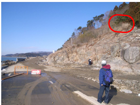
◆堤防高を大きく上回る水位痕跡（赤丸部）
