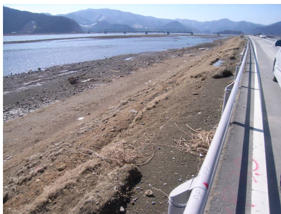
◆川側のり面：天端～のり肩部が侵食を受けている
