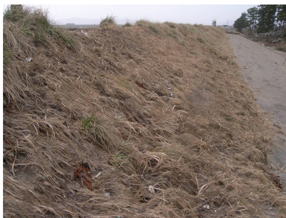
◆堤内側のり面
