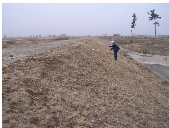
◆対照的に堤内側のり面では植生に目立った損傷なし
