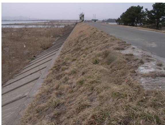
◆上写真のさらに上流：のり肩部の侵食から天端は冠水していたと推察される
