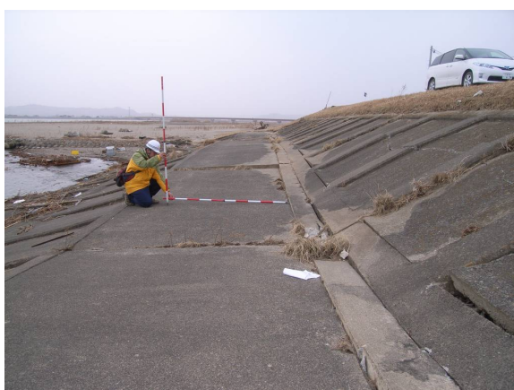
◆水門脇の護岸の陥没：地震動に起因するものと推察される
