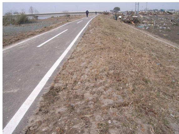
◆堤内側のり面
