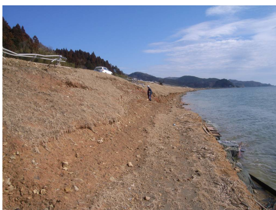
◆川側のり面：筋状の侵食域（下流を望む）
