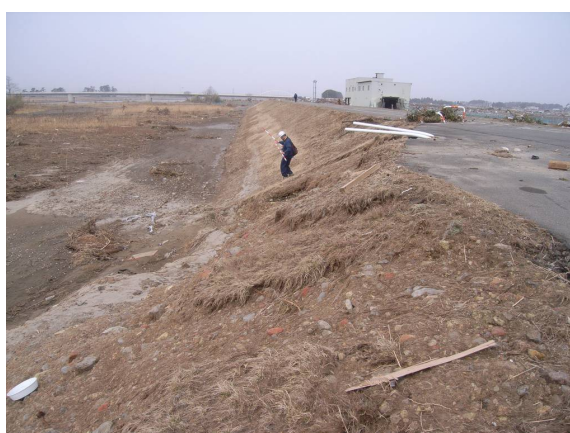
◆坂路上流ののり面では、他の箇所比べて損傷が著しかった
