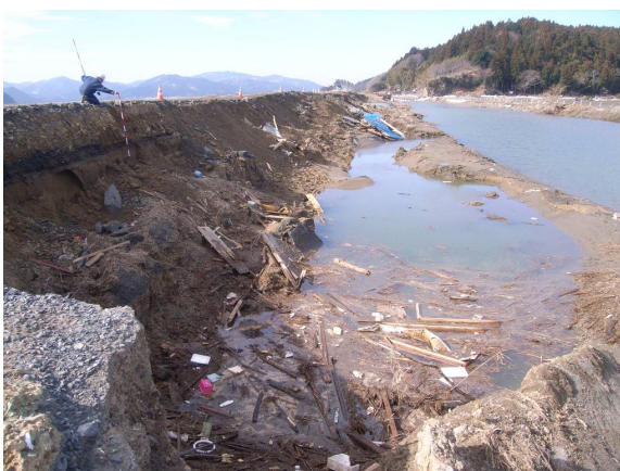
◆堤内側への越水によると考えられるのり面の侵食と落堀の形成
