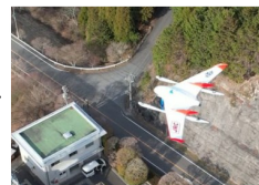
UAVによる河川巡視
