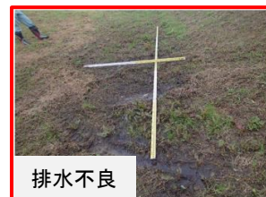
堤脚保護工の変形
