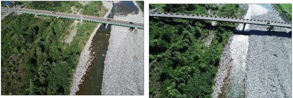
図 5-10 水面で太陽光が反射した場合の撮影画像（右写真）
